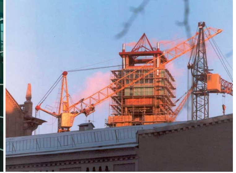
نهضة عمرانية في العاصمة داخل مركز جديد للأعمال
